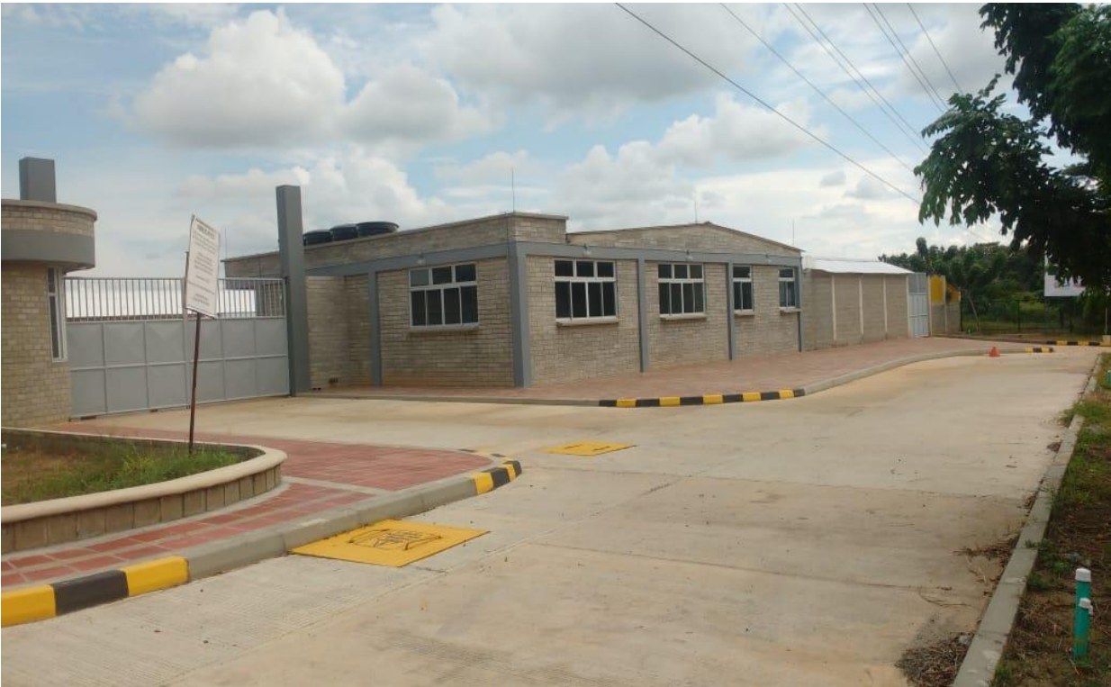
FACHADA DE LA NUEVA SEDE (primera etapa)
