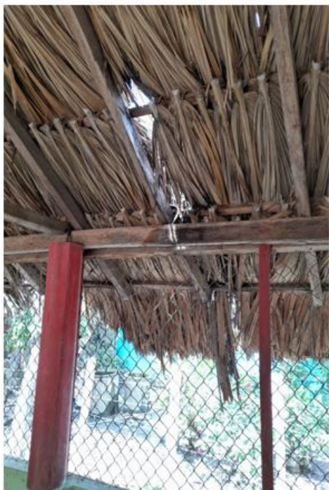
ARREGLO DE TECHOS SEDE EL CARMEN
