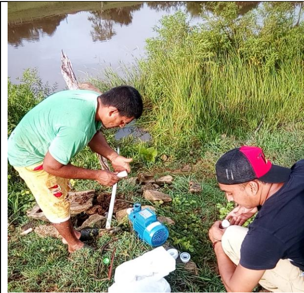
MANTENIMIENTO DE ELECTROBOMBA
