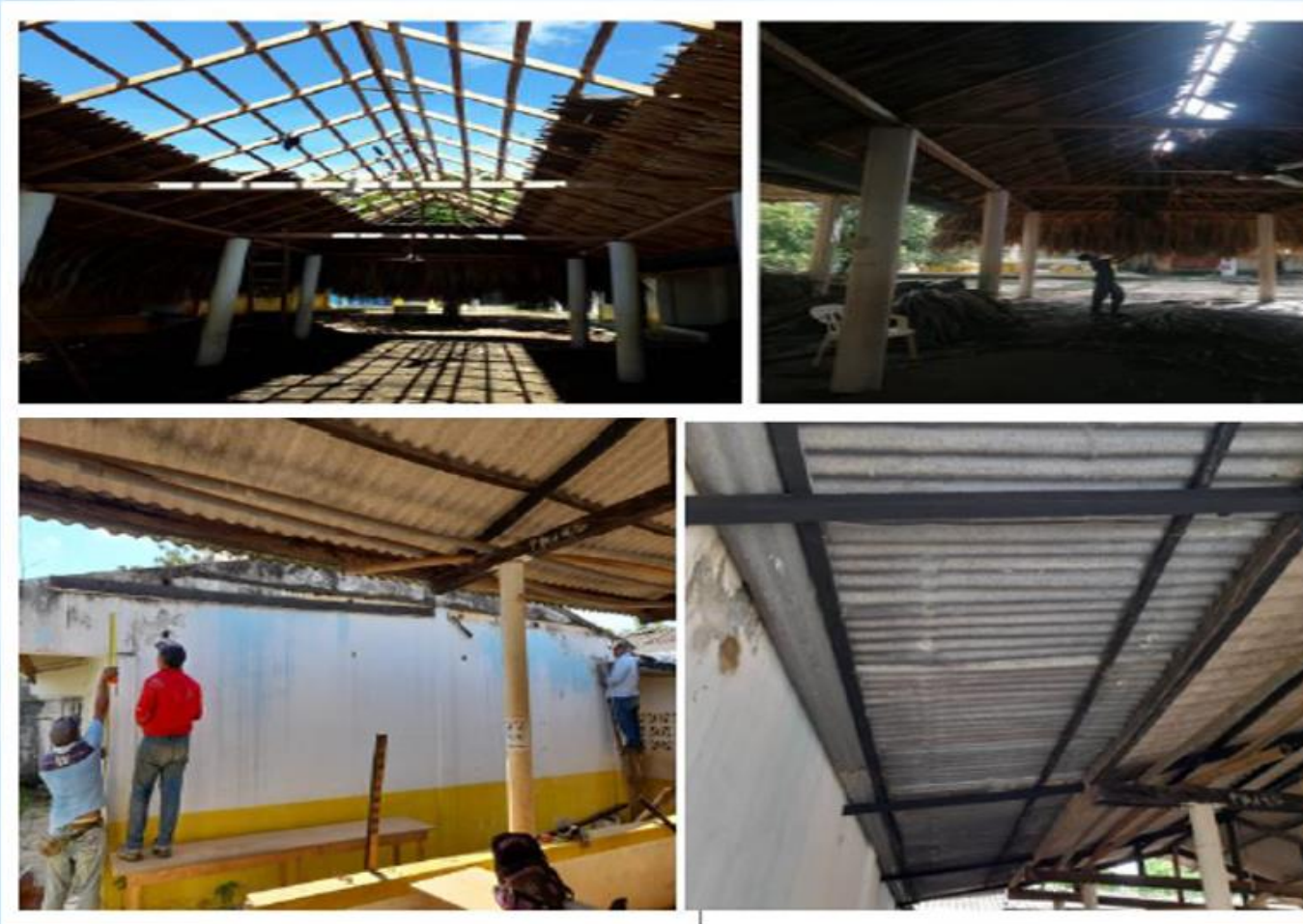
Cambio de palma amarga del kiosco de la sede principal - arreglo de techos sede Las Cruces
